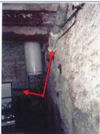
Photo n° PhA001 Localisation : RdC - Garage Ouvrage : 6 - Conduits et accessoires intérieurs - Vide-ordures Partie d'ouvrage : Conduit en fibres-ciment Description : Conduits en amiante ciment
